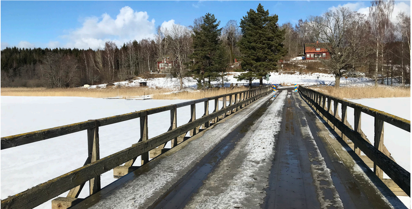
Entreprenören för projektet är utsedd men arbetet kan komma igång först när isen är borta på Inbåven. Foto: Trafikverket.
